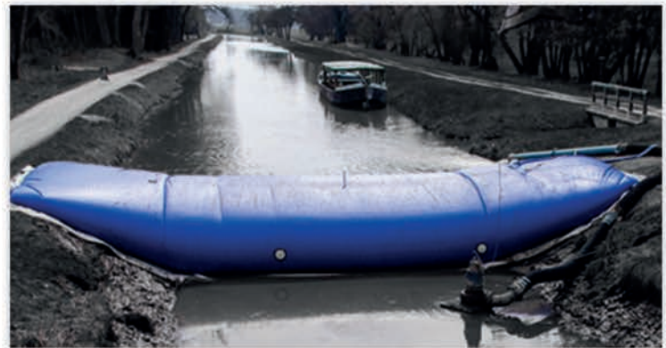
Wasserbau - 25 m - Wassertiefe: 1,80 m Aufbauzeit: 2,5 Stunden
