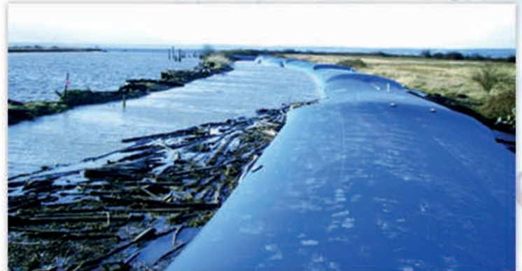
Hochwasserschutz - 270 m - Wassertiefe: 1,80 m Aufbauzeit: 6 Stunden
